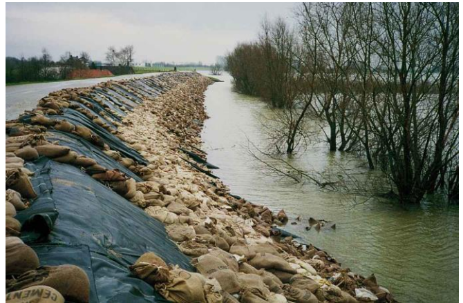
Figuur 2: De dijk bij Ochten, die door soldaten met duizenden zandzakken is verstevigd. Bron: Mijngelderland.nl
